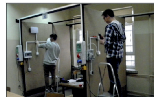
pracownia instalacji elektrycznych
